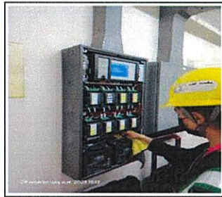
ทดสอบและทำความสะอาด Control Panel/Graphic Annunciator(ปั๊ม ร.ป.ภ)
