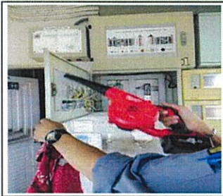
ทดสอบและทำความสะอาด Control Panel/Graphic Annunciator(ปั๊ม ร.ป.ภ)
