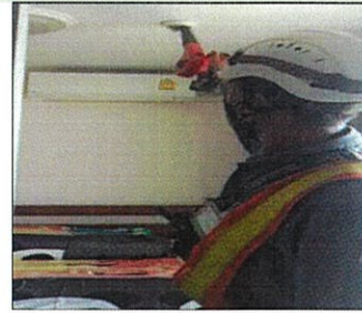
ทดสอบและทำความสะอาด อุปกรณ์ตรวจควัน ( Smoke Detector )
