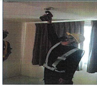
ทดสอบและทำความสะอาด อุปกรณ์ตรวจควัน ( Smoke Detector )
