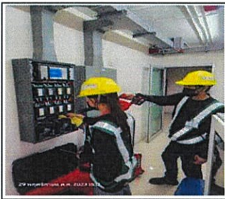
ทดสอบและทำความสะอาด Control Panel/Graphic Annunciator(ปั๊ม ร.ป.ภ)
