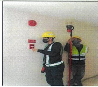
ทดสอบและทำความสะอาด อุปกรณ์แจ้งการด้วยมือ ( Manual Station )/อุปกรณ์แจ้งเตือน Alarm Bell
