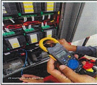
Control Panel ตรวจเช็คแรงดันไฟฟ้า AC Voltage /แรงดันไฟฟ้า Battery Voltage/ ทำความสะอาด Control Panel
