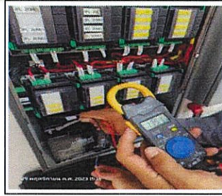
Control Panel ตรวจเช็คแรงดันไฟฟ้า AC Voltage /แรงดันไฟฟ้า Battery Voltage/ ทำความสะอาด Control Panel
