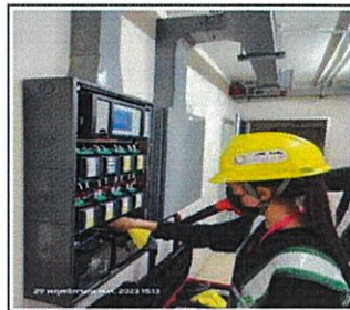
ทดสอบและทำความสะอาด Control Panel/Graphic Annunciator(ปั๊ม ร.ป.ภ)
