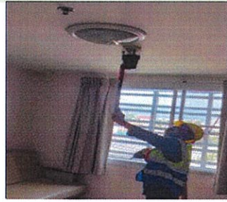
ทดสอบ อุปกรณ์ตรวจจับความร้อน ( Heat Detector )
