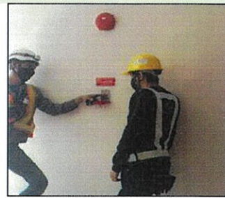
ทดสอบและทำความสะอาด อุปกรณ์แจ้งการด้วยมือ ( Manual Station )/อุปกรณ์แจ้งเตือน Alarm Bell
