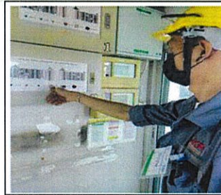
ทดสอบและทำความสะอาด Control Panel/Graphic Annunciator(ปั๊ม ร.ป.ภ)
