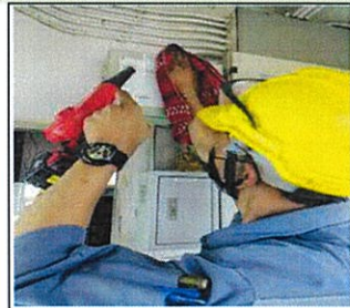
ทดสอบและทำความสะอาด Control Panel/Graphic Annunciator(ปั๊ม ร.ป.ภ)
