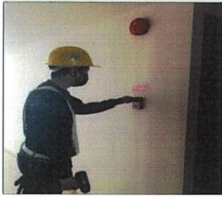
ทดสอบและทำความสะอาด อุปกรณ์แจ้งการด้วยมือ ( Manual Station )/อุปกรณ์แจ้งเตือน Alarm Bell
