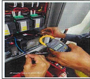
Control Panel ตรวจเช็คแรงดันไฟฟ้า AC Voltage /แรงดันไฟฟ้า Battery Voltage/ ทำความสะอาด Control Panel
